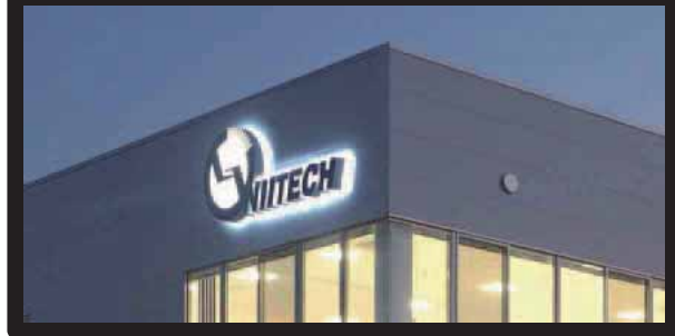
バックライト文字(マークは面発光、バックライト併用)施工例
